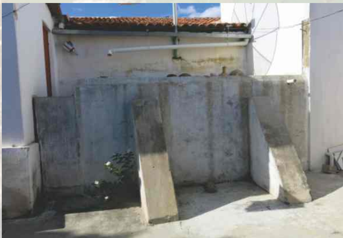
Primeira cisterna construída por Seu Heleno.
