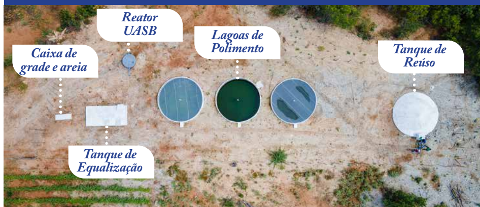
Imagem 08 – Visão área do sistema de tratamento do esgoto total comunitário – Foto: Fábio Arruda
