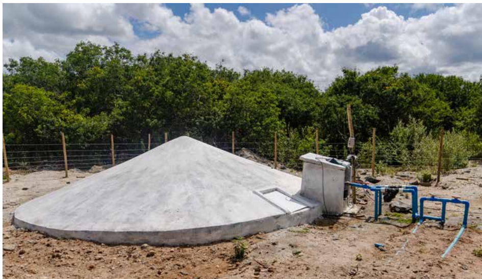
Imagem 17 – Tanque de reuso – foto: Fábio Arruda
