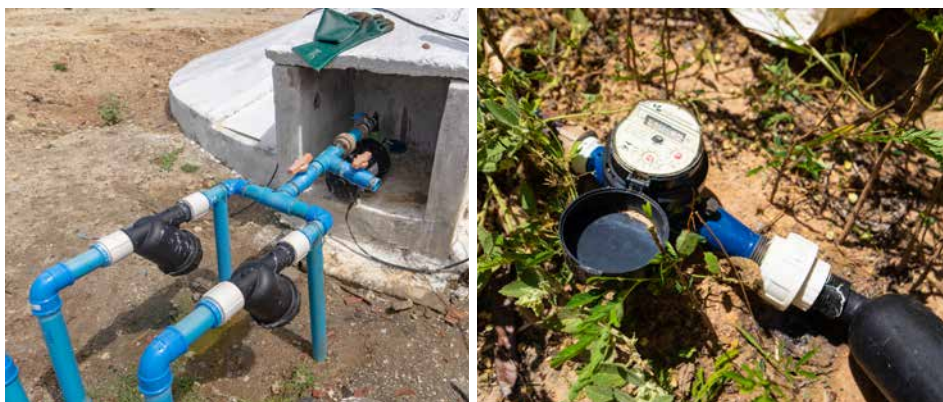
Imagem 18 – Filtros de irrigação usado após tanque de reuso, nos sistemas coletivos e familiar.
