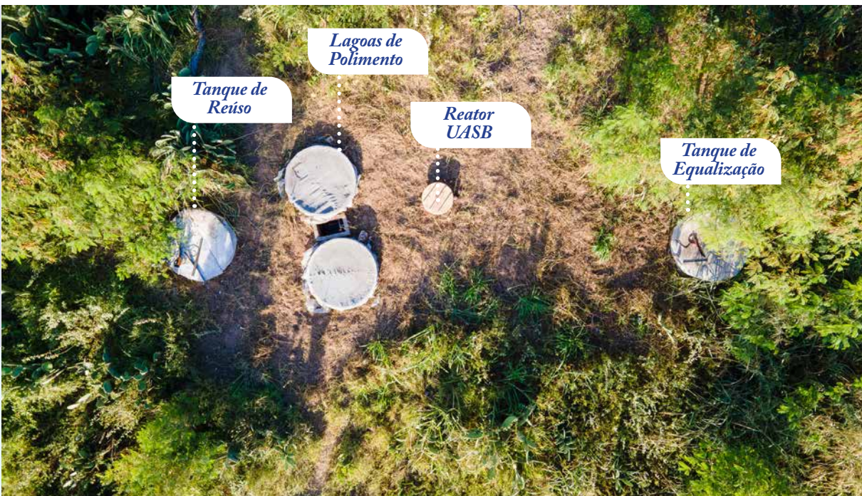
Imagem 05 – Visão área do sistema de tratamento do esgoto total familiar – Foto: Fábio Arruda
