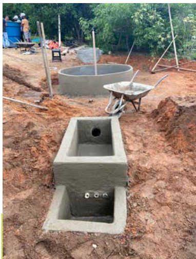
Caixa de descarga enterrada. Acervo: Pró Semiárido.
