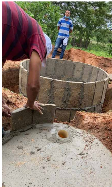
Base da caixa com tubulação no fundo e assentamento das placas sob a base. Acervo: Pró Semiárido.
