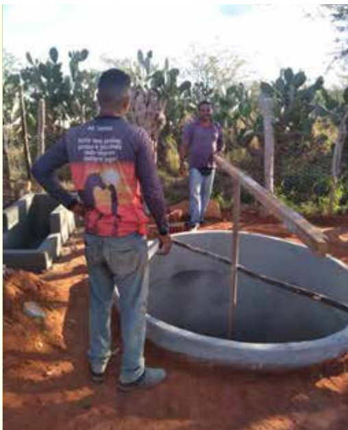
Trave de segurança fixado no cano guia. Foto: Acervo Pró Semiárido
