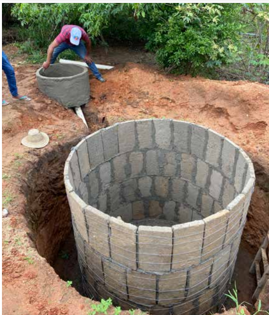
Amarração do tanque em placas com arame galvanizado. Acervo: Pró Semiárido.
