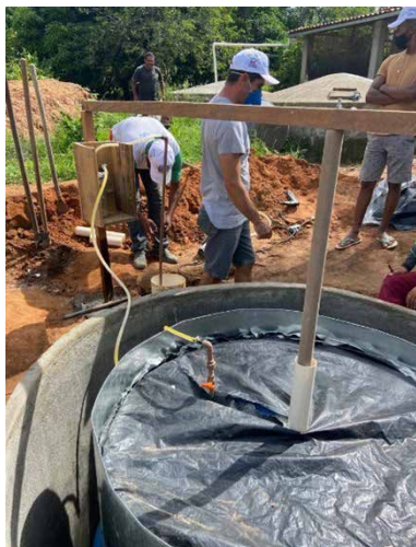
Caixa forrada com lona plástica Acervo: Pró Semiárido.
