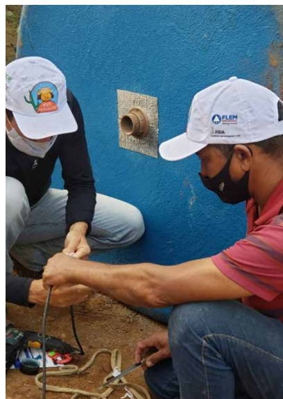
Instalação do flange no centro da caixa. Acervo: Pró Semiárido.
