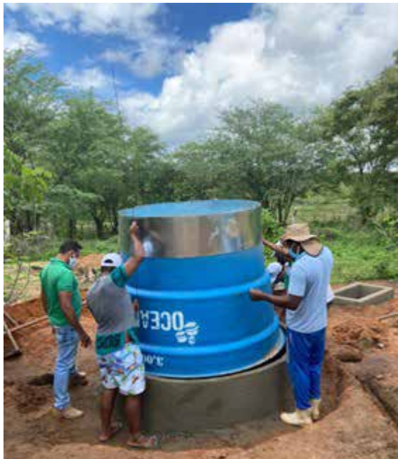
Fita de zinco instalada na caixa. Acervo: Pró Semiárido.
