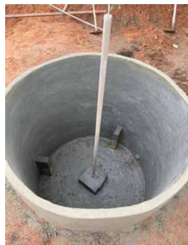
Batentes construídos com altura acima do cano de descarga. Acervo: Pró Semiárido.
