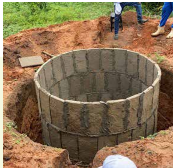
Parede do tanque em placas Foto: Acervo Pró Semiárido
