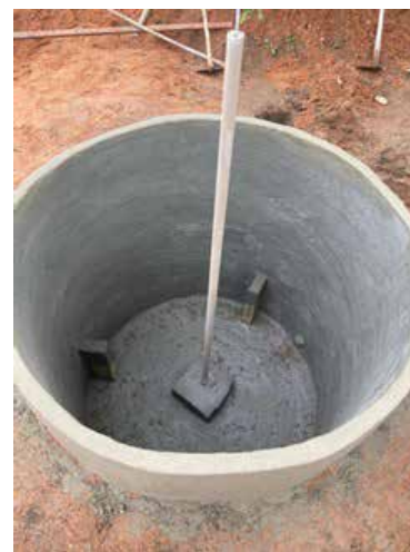
Sapata de fixação do cano guia. Foto: Acervo Pró Semiárido
