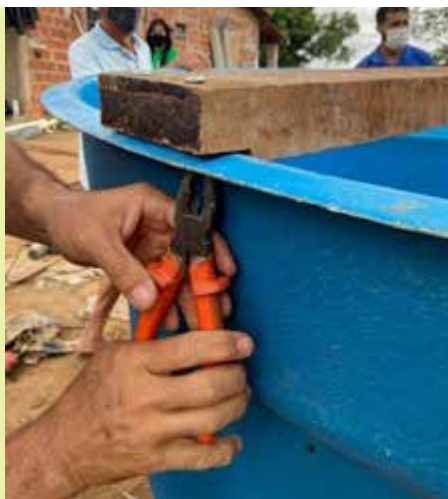
Fixação da tábua, do cano guia, na caixa. Acervo: Pró Semiárido.
