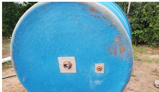
Flanges instalados na caixa. Acervo: Pró Semiárido.
