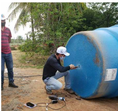
Marcação do ponto central da caixa. Acervo: Pró Semiárido.
