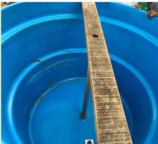
Base do cano guia instalado na caixa. Acervo: Pró Semiárido.
