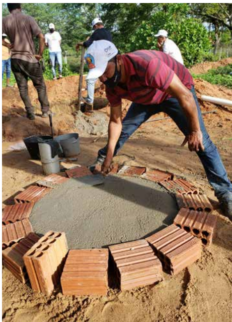
Base da caixa de carga. Acervo: Pró Semiárido
