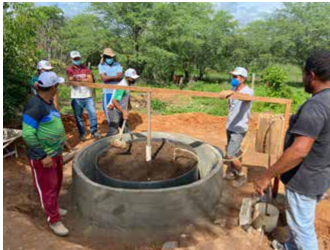
Lastro com terra por cima do forro em manta de fibra. Acervo: Pró Semiárido
