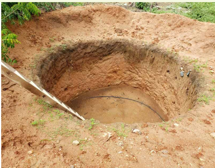
Escavação do tanque finalizada Foto: Acervo Pró Semiárido.
